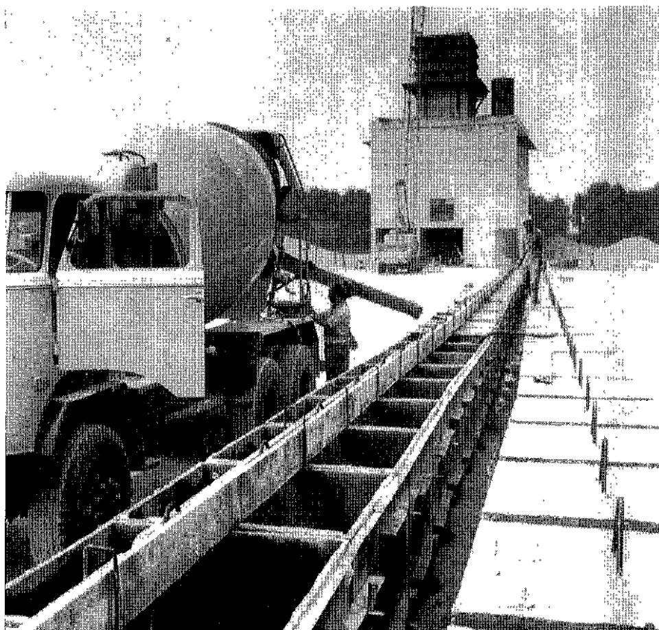
Een truckmixer stort beton in de houten bekisting
